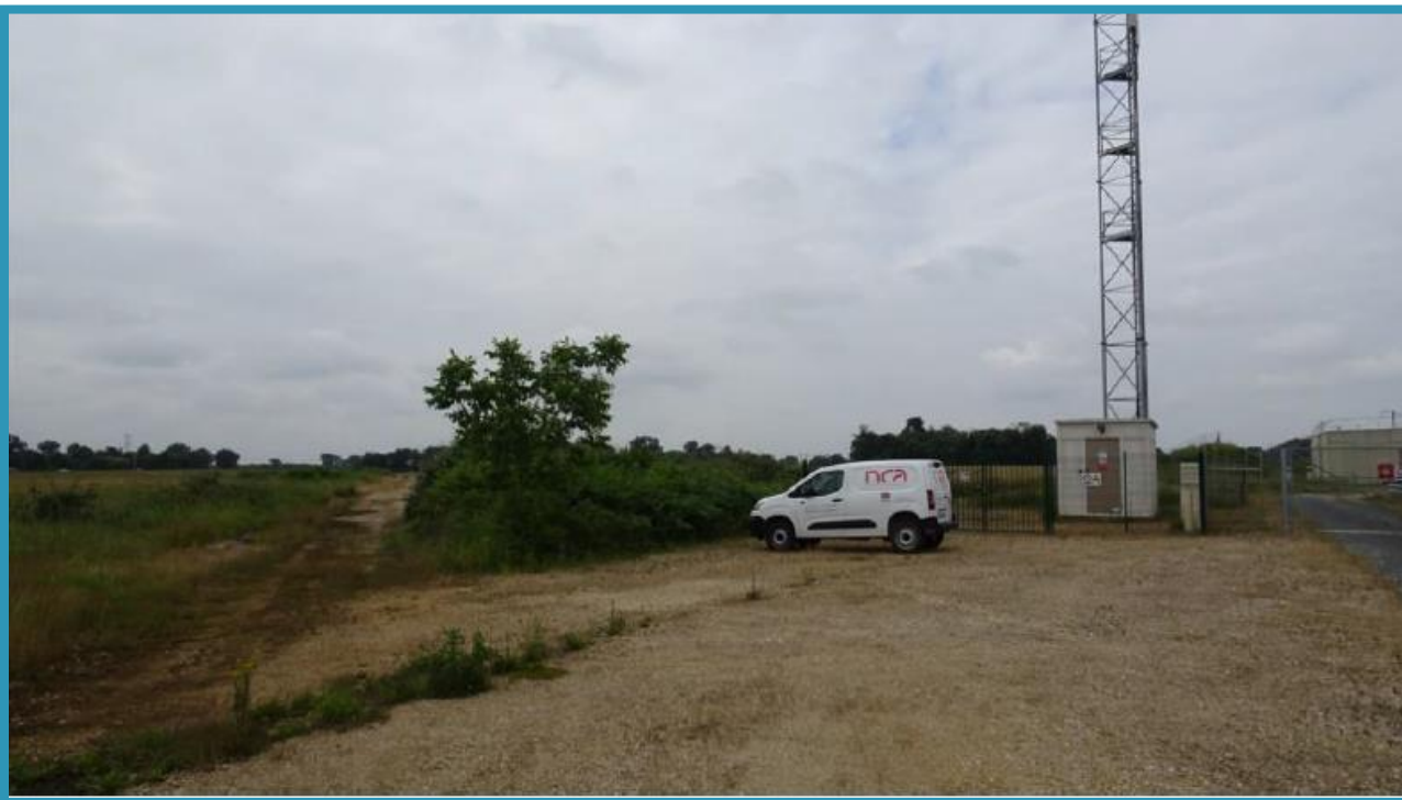
Photographie du poste de transformation électrique de la LGV Sud Europe Atlantique
