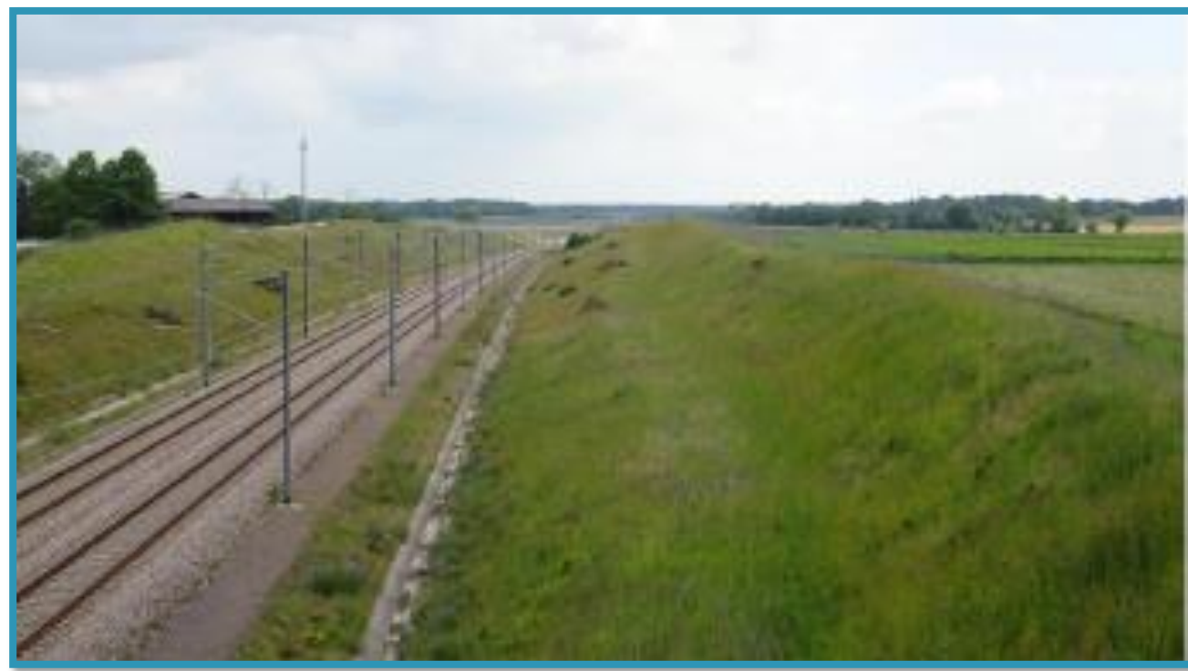
Photographie des remblais contenant la LGV Sud Europe Atlantique
