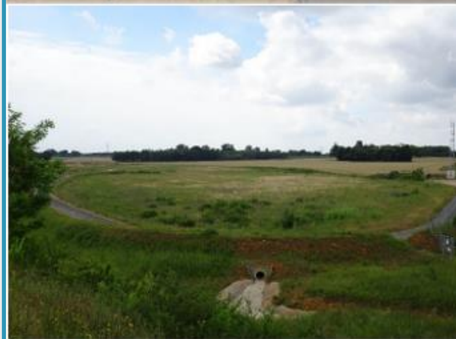
Photographie de l'état initial
