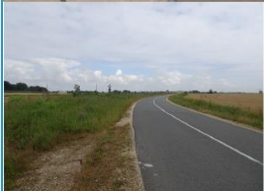
Photographie de l'état initial
